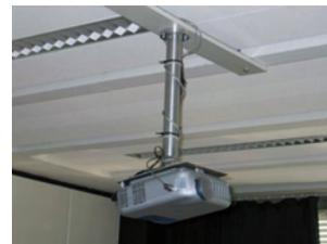
weist die Länge  $l$  sowie den Radius  $r$  auf und besteht aus einem Kunststoff (Dichte  $\rho$ , E-Modul  $E$ ). Die Verbindung mit der Decke ist dabei als Einspannung anzusehen. Die Spannungsverteilung für dieses Problem wurde bereits in **Aufgabe 2.2** berechnet. Bestimmen Sie die sich in Folge der Belastung einstellende Absenkung des Beamer's am unteren Ende des Stabes.
