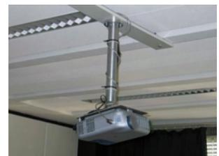
weist die Länge  $l$  sowie den Radius  $r$  auf und besteht aus einem Material der Dichte  $\rho$ . Die Verbindung mit der Decke ist dabei als Einspannung anzusehen. Bestimmen Sie die Spannungsverteilung im Stab sowie die maximal zulässige Masse  $m_{\max}$  des Beamers, damit die zulässige Normalspannung  $\sigma_{\text{zul}}$  nicht überschritten wird.
